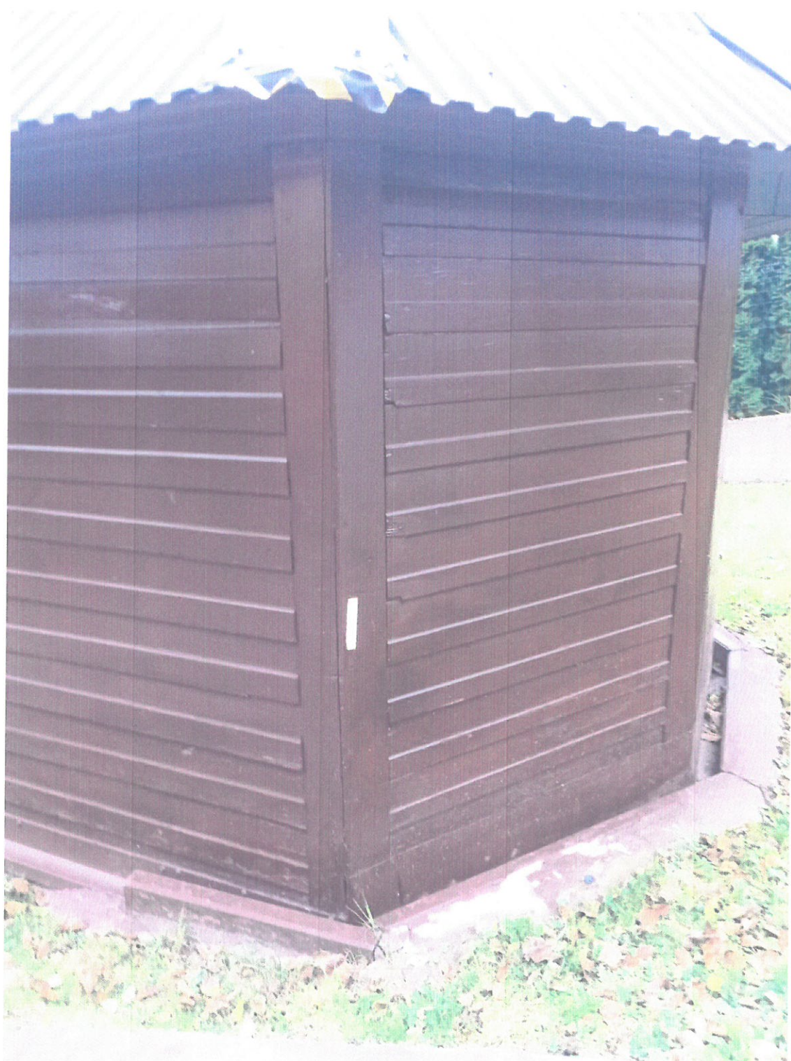
3. Il. Bysina, kapliczka domkowa datowana na połowę XIX w. Stan zachowania przed rozpoczęciem prac konserwatorskich. Ukazany fragment ściany wskazuje na misterną pracę stolarza dbającego o szczegół. Niestety nie posiadał on jednak wiedzy i doświadczenia przy tego typu obiektach, co skutkuje niewłaściwym układem desek, zbyt dokładnym powtórzeniem ich wymiarów itp. Fot. 2024 r.
