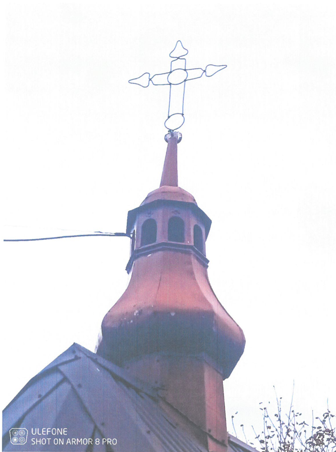
2. Il. Bysina, kapliczka domkowa datowana na połowę XIX w. Stan zachowania przed rozpoczęciem prac konserwatorskich. Ujęcie helmu sygnaturki od strony południowej. Obecnie pokrywa go monochromatyczna powłoka malarska o odcieniu czerwieni. Miejscami widoczne wgniecenia i nieznaczne ubytki. Fot. 2024 r.
