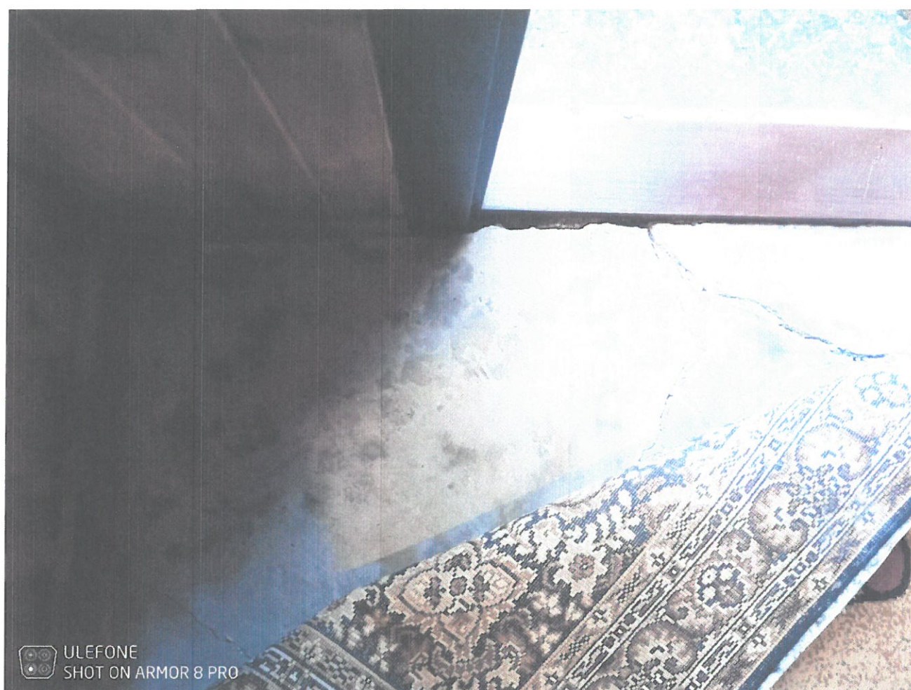
8. Il. Bysina, kapliczka domkowa datowana na połowę XIX w. Stan zachowania przed rozpoczęciem prac konserwatorskich. Przedstawione ujęcie stanowi niewielki fragment podłogi zalanej w przeszłości płynnym betonem. Obecnie w całości zakrywają tę część wnętrza dywany. Fot. 2024 r.
