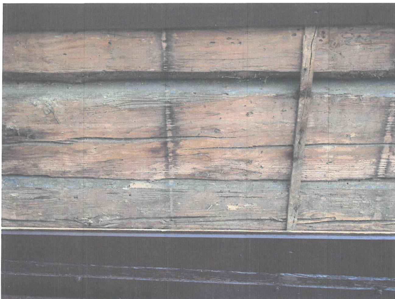
10. Il. Bysina, kapliczka domkowa datowana na połowę XIX w. Stan zachowania przed rozpoczęciem prac konserwatorskich. Widoczne ślady po wcześniejszych murłatach oraz ta zachowana obecnie. Z bliższej perspektywy można było dostrzec dużą ilość świeżego pyłku drzewnego, co wskazuje na aktywną działalność drewnojadów. Fot. 2024 r.
