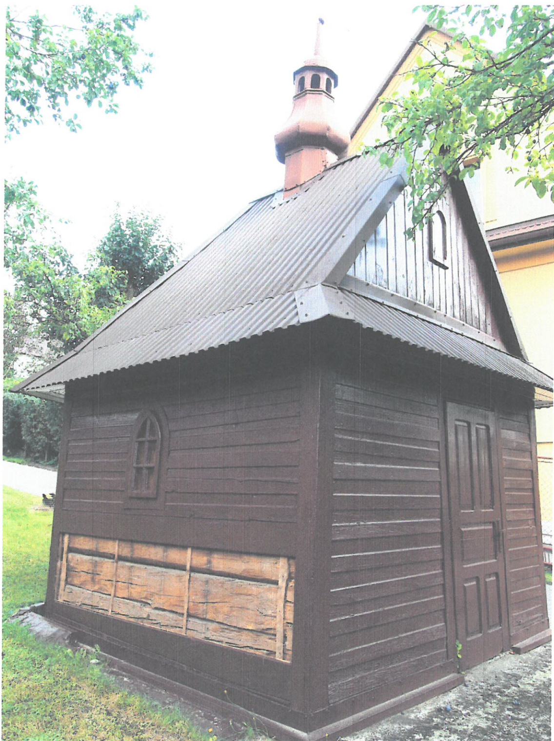
9. Il. Bysina, kapliczka domkowa datowana na połowę II połowa XIX w. Stan zachowania przed rozpoczęciem prac konserwatorskich. Widok od strony wschodniej. Tymczasowy demontaż kilku desek elewacji pozwolił na ocenę stanu zachowania belek zrębowych tworzących ściany kapliczki. Dopiero dokładniejsze badania dendro-hronologiczne mogłyby pozwolić na dokładne datowanie drewna użytego do jej budowy oraz wskazać ich gatunek. Fot. 2024 r.
